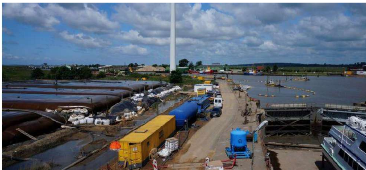
Figure 84 : Illustration du chantier de Husum (géotubes à gauche de la photo).
