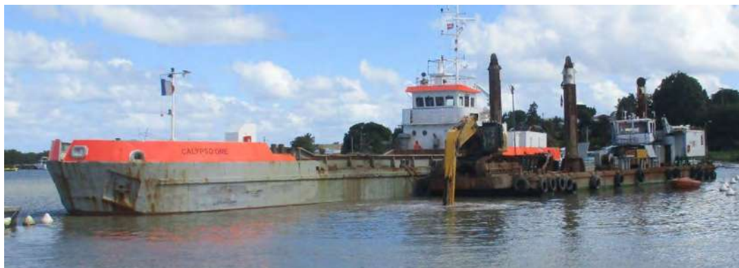
Figure 2-6 : Illustration d'un atelier de dragage constitué d'un ponton avec une pelle et d'une barge fendable (source : CREOCEAN)
