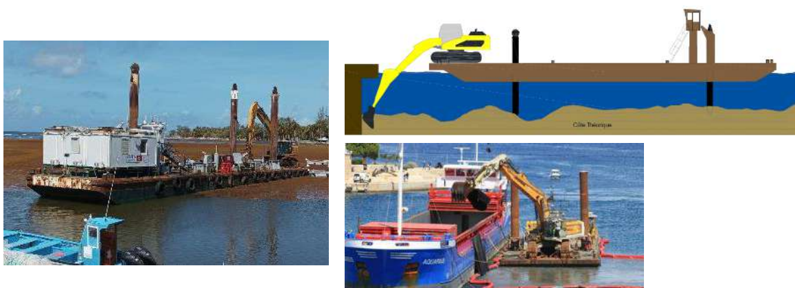
Figure 9 : Illustration d'un atelier de dragage classique composé d'un ponton dipper et d'une barge fendable
