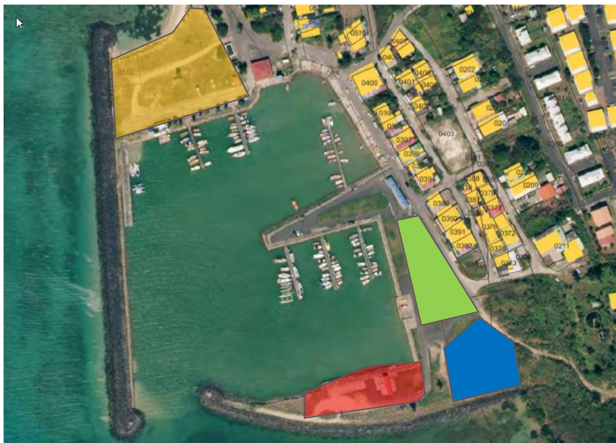
Figure 2 : Localisation des différents bâtis aux abords du port départemental (jaune : bâtiments identifiés)
